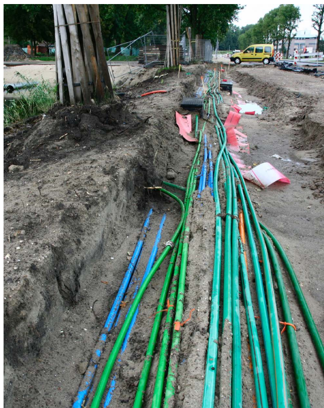
Afstand boom tot ondergrondse kabels en leidingen (foto: Hans Kaljee)
