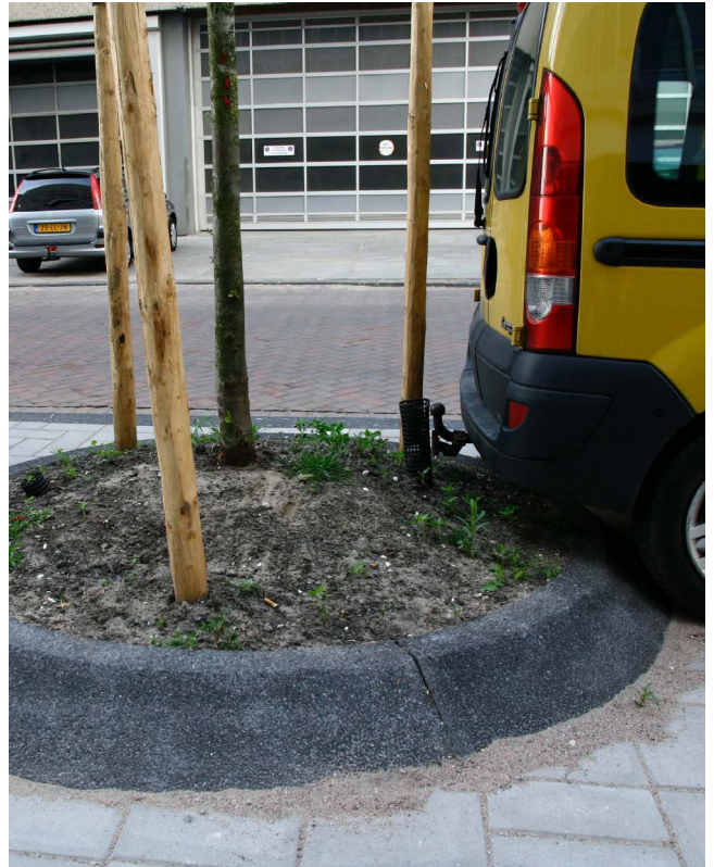
Verhoogde boomspiegels bij parkeren à niveau en voldoende afstand tussen achterkant auto en stam (foto: Hans Kaljee)
