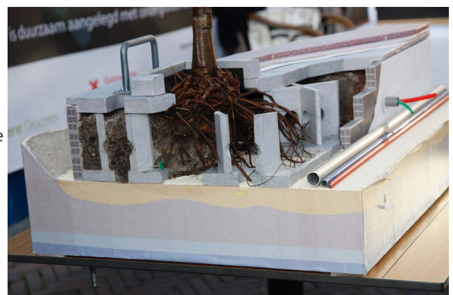
Maquette van technische constructie bij bomen langs gracht
