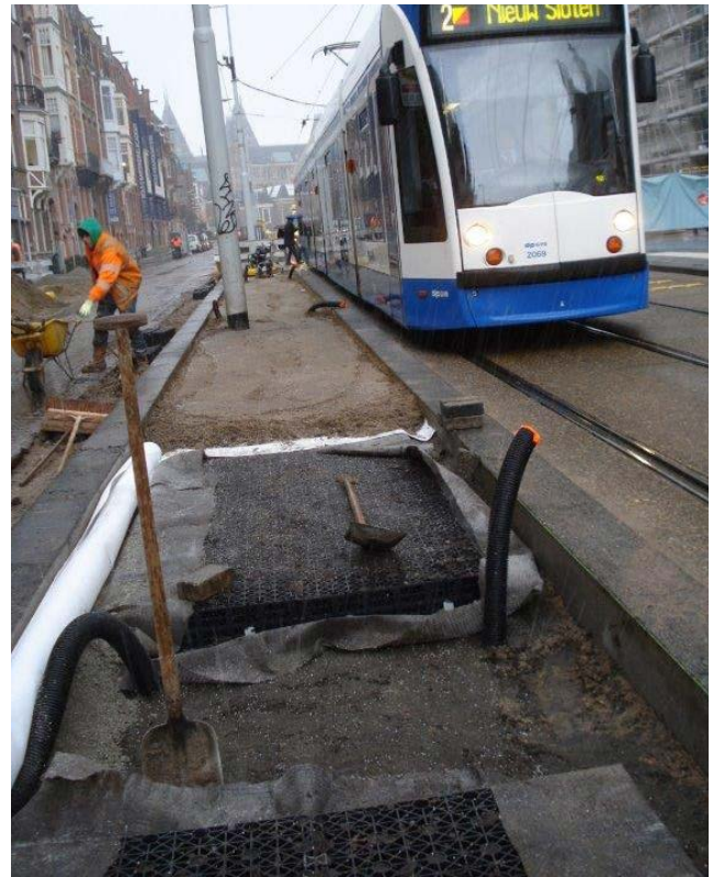
In verharde situatie wordt sandwichconstructie aangebracht, Paulus Potterstraat (foto: Jan Willem Obbink)
