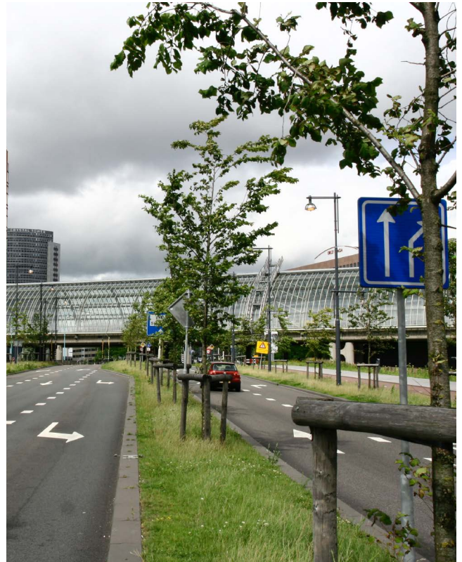
Profiel van vrije ruimte bij middenberm (foto: Hans Kaljee)
